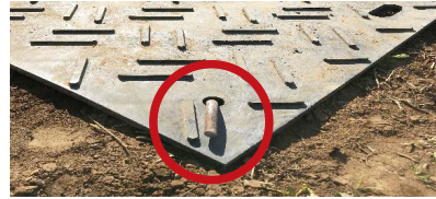
L字アンカー施工例
